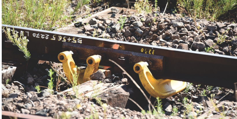
Streckenertüchtigung à la française im Bahnhof Lauterbourg Gleis 2 – hier verkehrten täglich schwere Güterzüge, teils mit Gefahrgut.
