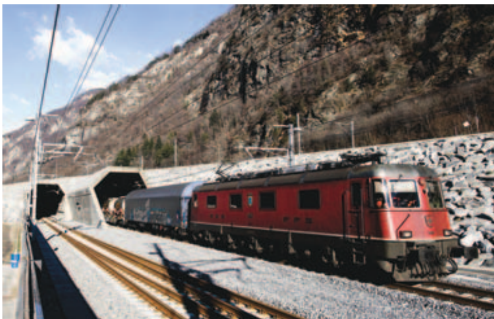
Erste Test-Güterzüge durchfahren im Januar 2016 den Gotthard-Basistunnel.
