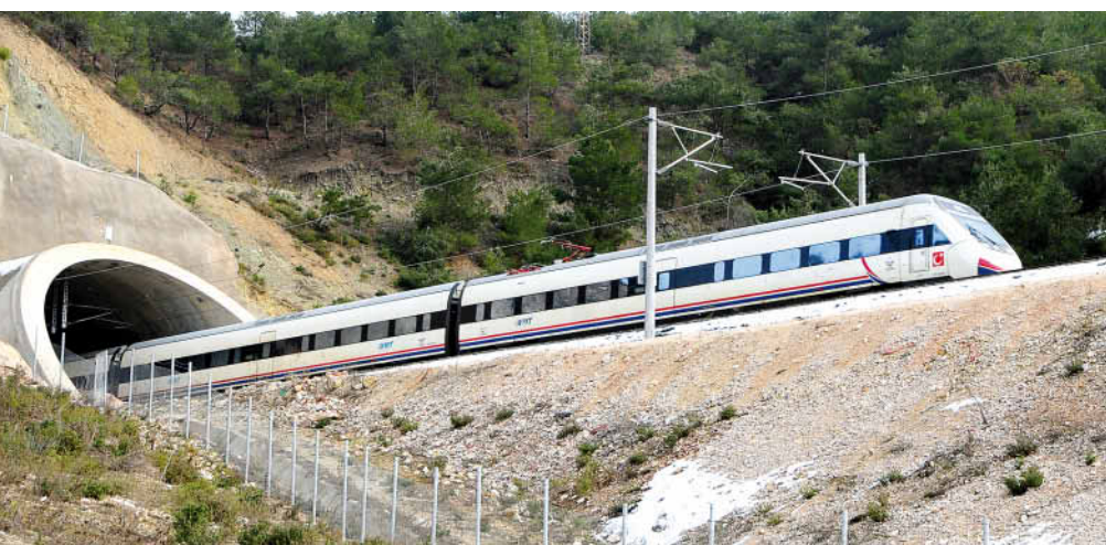
Mit Unterstützung chinesischer Ingenieurskunst und Finanzierung wurde die 250-km/h-Strecke von Eskişehir nach Istanbul/Pendik gebaut: 28 Tunnel, 22 Viadukte und 27 Brücken waren zu erstellen. Insgesamt wurden 24 Millionen Kubikmeter Gestein verschoben.
