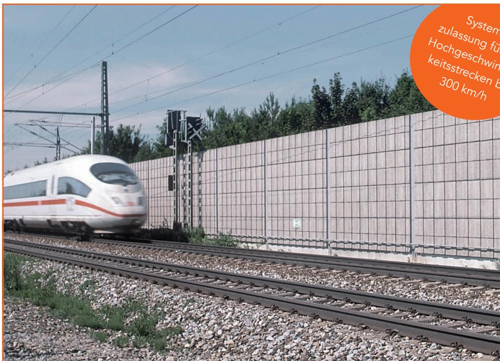
Hochabsorbierende Lärmschutzwände aus Holzbeton
